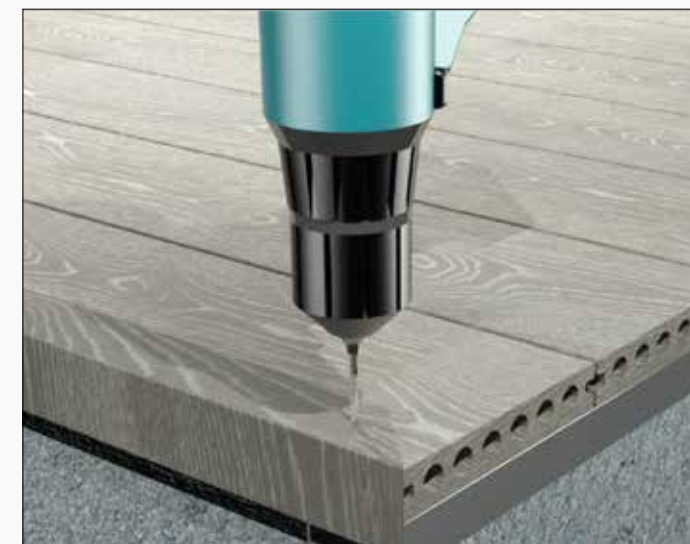
5) Forare con punta da legno di 3 mm, ad una profondità di 25 mm
