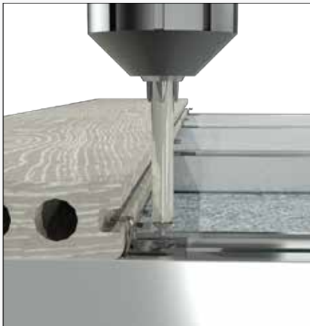
3) Stellen Sie sicher, dass die Clips an der Latte haften
