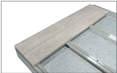
7) Installation von zwei Latten
