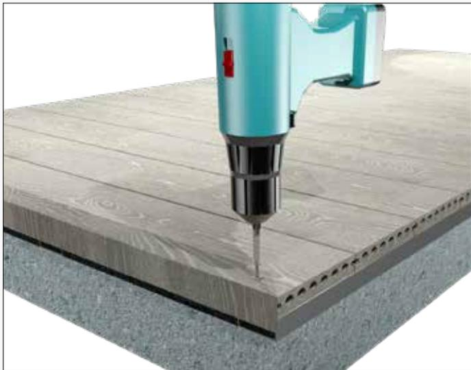
6) Setzen Sie die Schraube in das gerade erstellte Loch ein und denken Sie daran, die mitgelieferte Kunststoffunterscheibe zu verwenden
