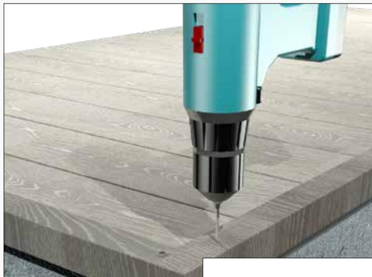
9) Bohren Sie mit einem 3 mm Holzbohrer
