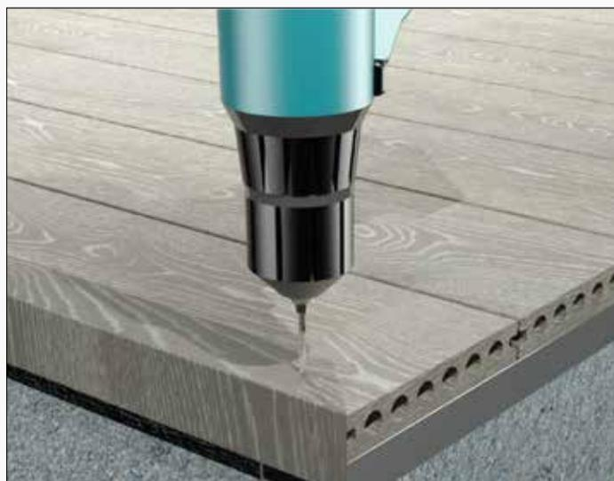
5) Bohren Sie mit einem 3 mm Holzbohrer bis zu einer Tiefe von 25 mm
