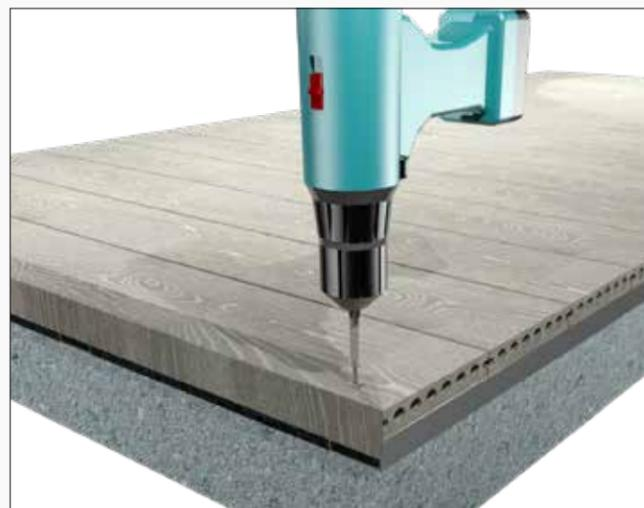
6) Inserire la vite nel foro appena creato, ricordandosi di utilizzare la rondella in plastica fornita in dotazione
