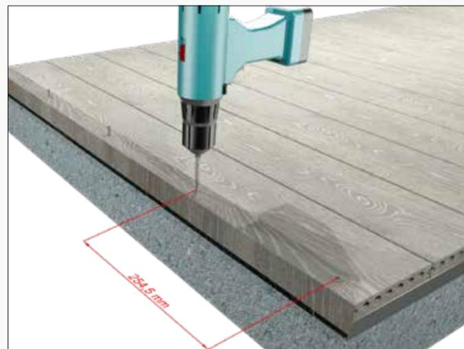
7) Effettuare lavorazione di foratura ed avvitatura ogni 254,5 mm
