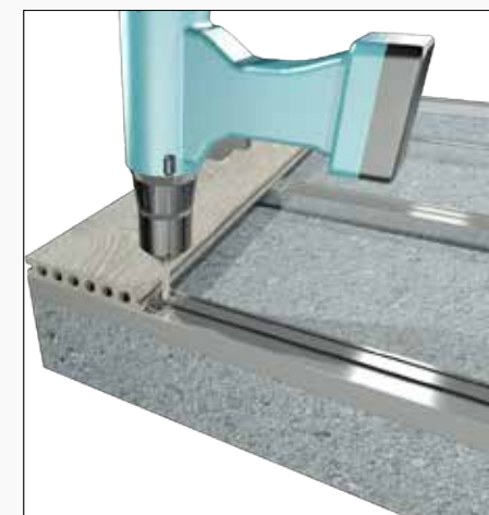
2) Avvitare la clip in acciaio
