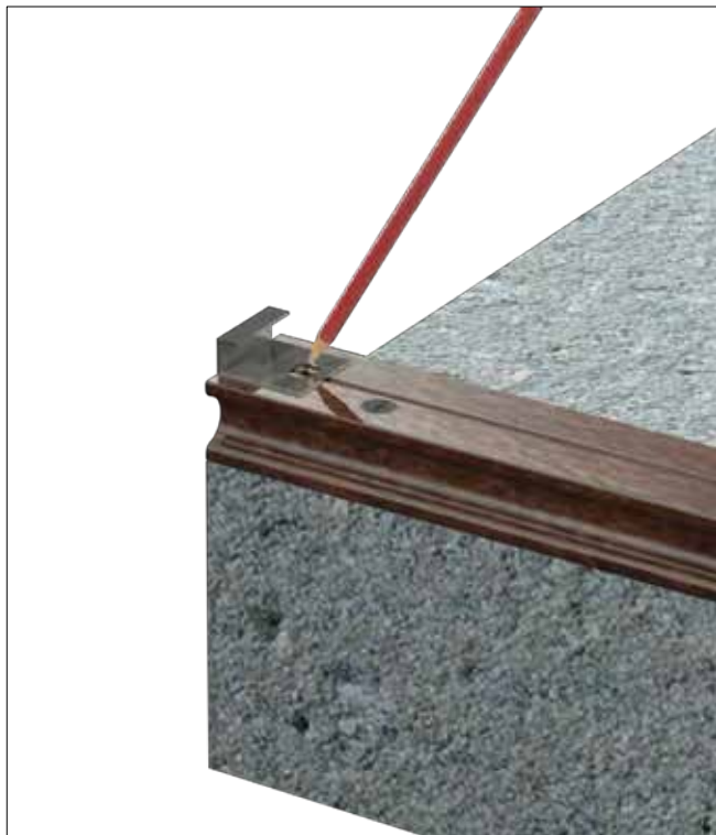
1) UTILIZZARE LA START CLIPS COME MASCHERA PER EFFTUARE IL SEGNO DOVE ANDRA' EFFETTUATA LA FORATURA (FIG.2)
